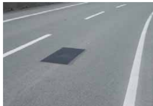
写真 2 簡易車両感知器を道路に設置した状況
