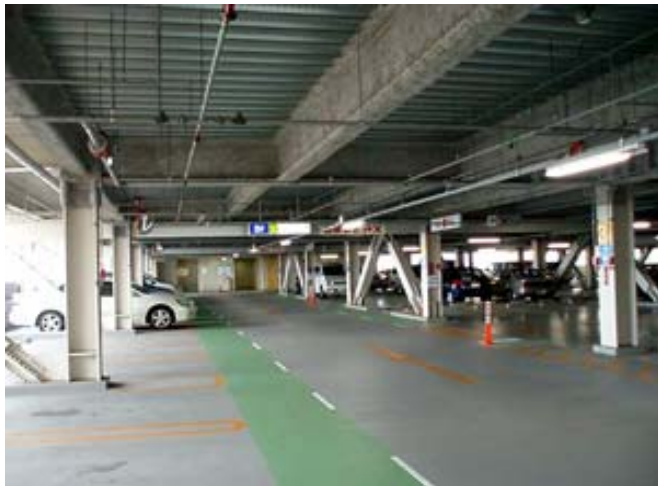
Parking lots for P&R パーク&ライドに用いられる駐車場
